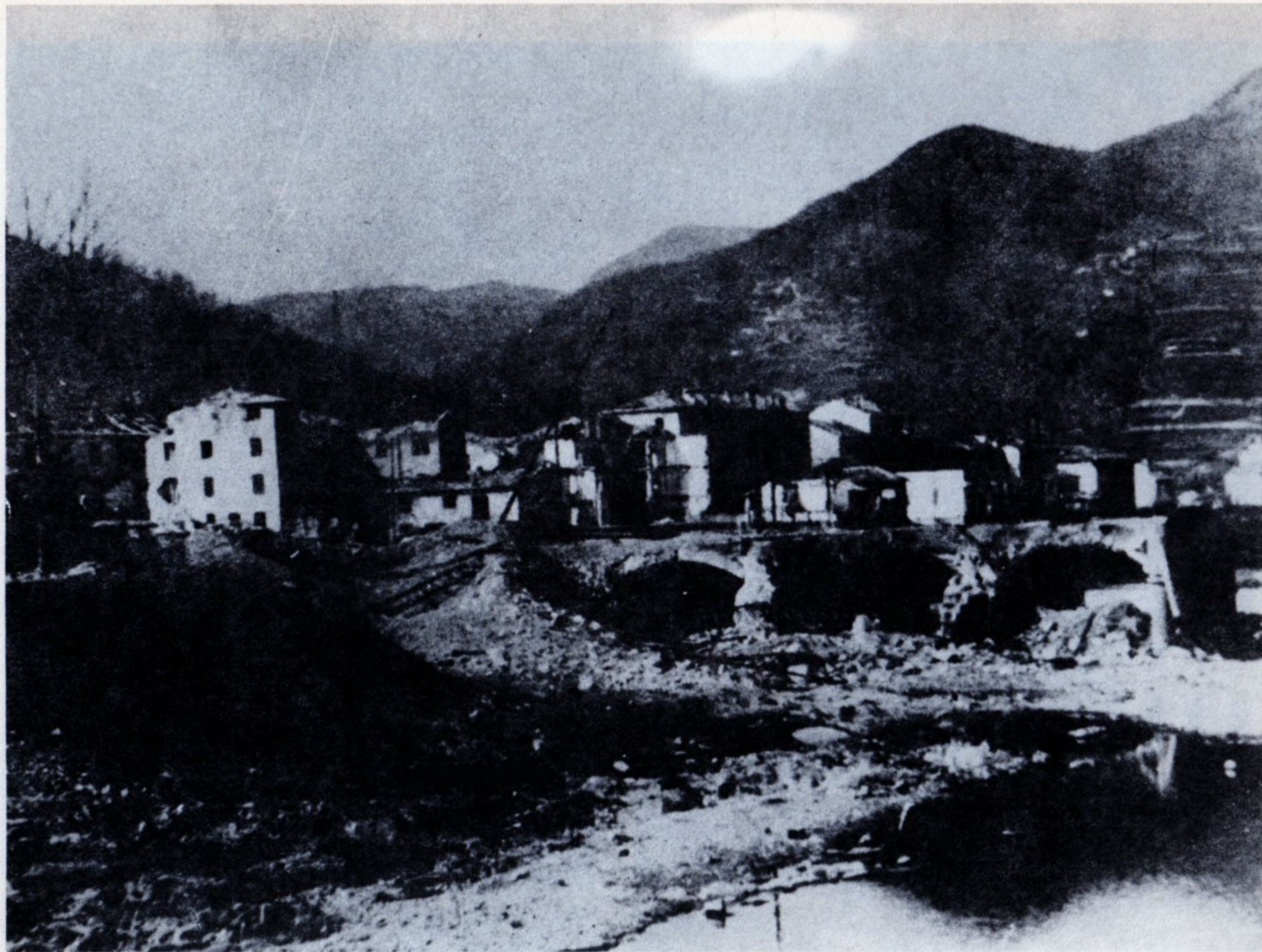
L'obiettivo dei bombardamenti «il ponte ferroviario»
